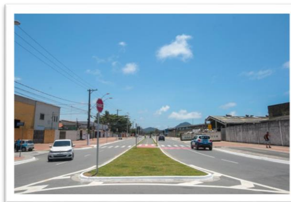
Reurbanização da Avenida do Trabalhador
