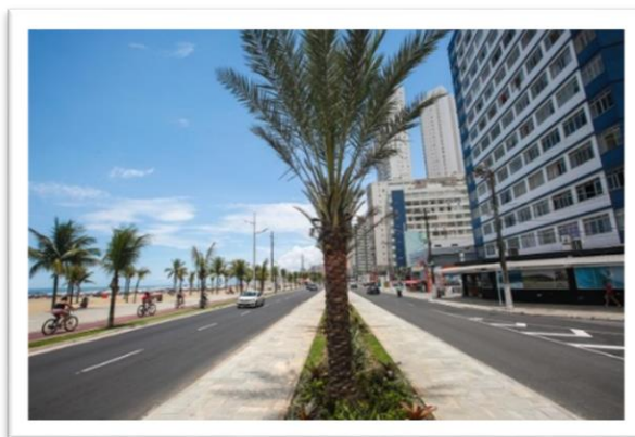
Remodelação da Av. Pres. Castelo Branco, no bairro Boqueirão
