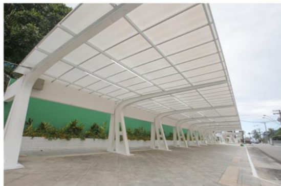
Remodelação da Avenida dos Sindicatos
