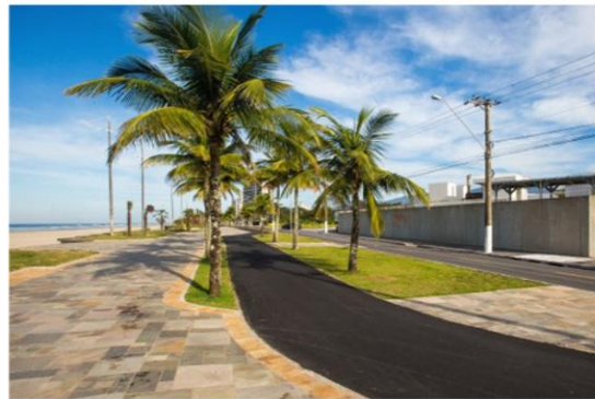
Revitalização do calçadão na orla no trecho Mirim-Solemar
